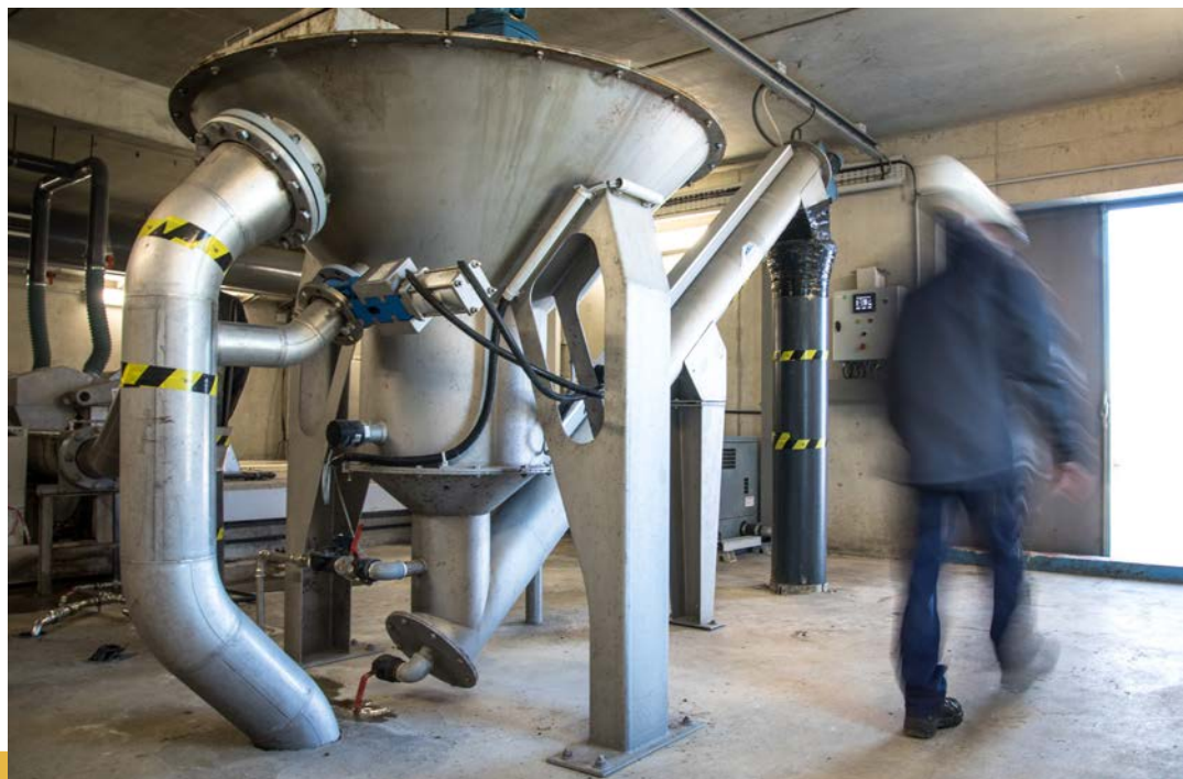
Florian Charols , contrôleur des travaux aux services techniques, ici à la station de La Saignonne
