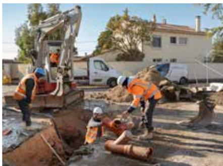
La mise en séparatif des réseaux d'assainissement de la commune de Vedène fait l'objet d'un projet porté par le Grand Avignon depuis déjà plusieurs années. Une nouvelle phase de travaux vise à la suppression des derniers réseaux unitaires de la commune, avec la **mise en place de canalisations** et d'**installations spécifiques et distinctes pour l'acheminement des eaux usées vers la station d'épuration** de Sorgues, d'une part, et à la circulation des eaux pluviales, d'autre part.
