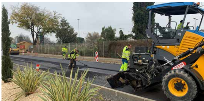
Chantier rue Graham Bell au Pontet
