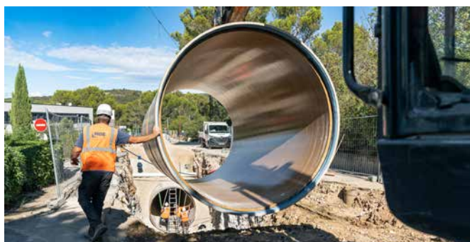
Travaux chemin des Rocailles
